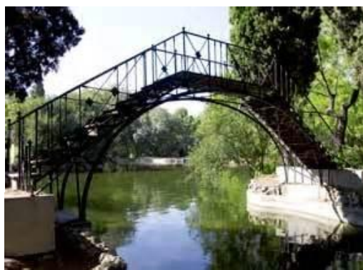
Puente de Hierro (Embarcadero)
